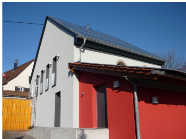
Ansicht aus dem Hof mit PV-Anlage
